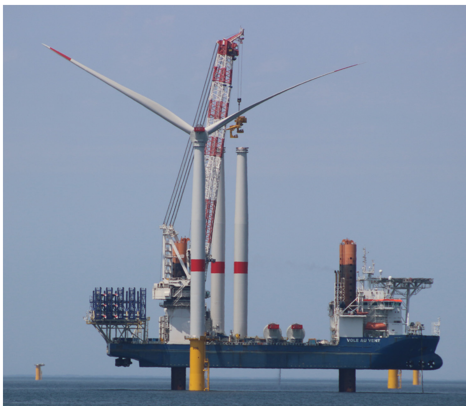
Montage d'une éolienne sur le parc éolien offshore de Saint-Nazaire
