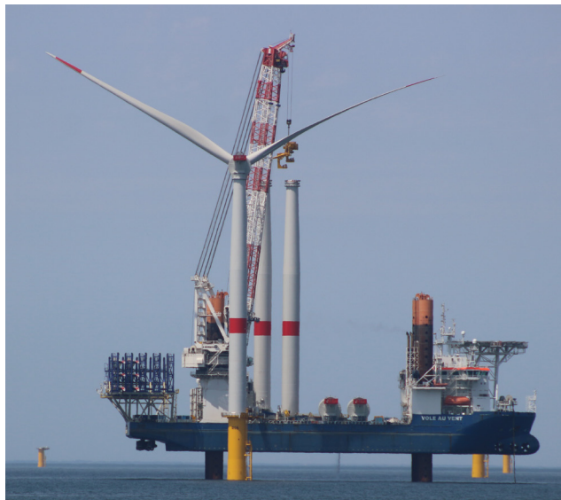
Montage d'une éolienne sur le parc éolien offshore de Saint-Nazaire
